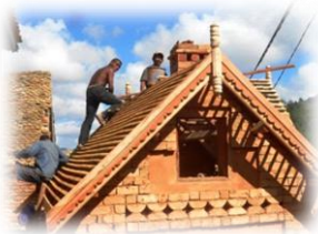
Des artisans restaurent le toit d'une maison traditionnelle. ©René Cassin 2013.
